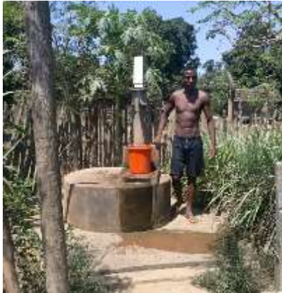
Figure 6 : Observation des pompe hydrauliques
