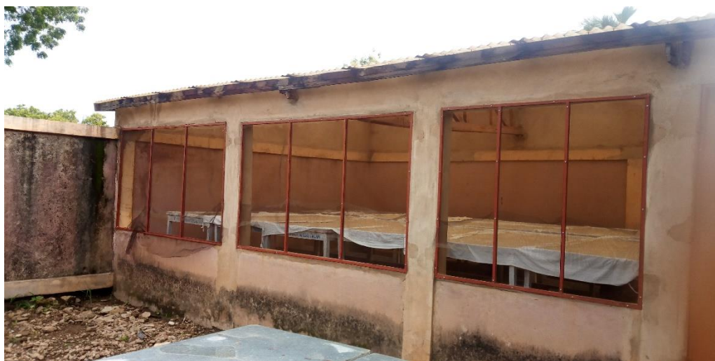
Photographie 26: Aire de séchage sécurisé et hygiénique (Site ONG Tikonna, Boukombé). Crédit photo : Natta A.K. 2019.
