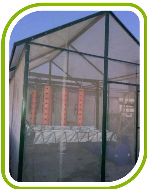
Figura N° 4. Tubos de PVC colgados, instalados dentro del invernadero
